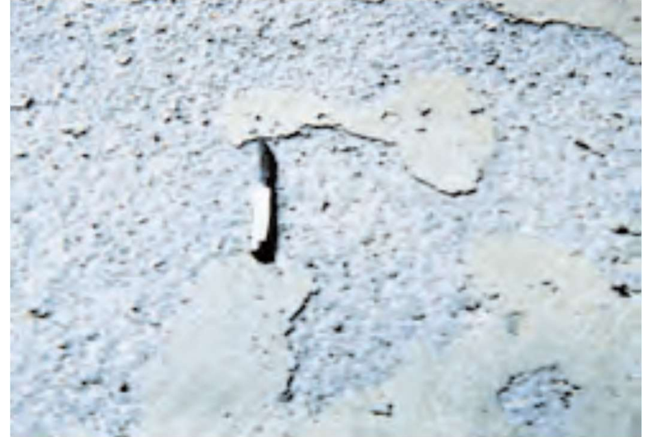
تقشر سطح الخرسانة نتيجة عدم استخدام مولدات الفقاعات ضمنها، عند تعرضها لأملح الازابة.
