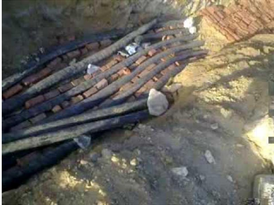
شكل -13- الدفن المباشر للقابلات الكهربائي تحت الارض
