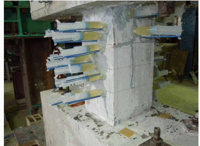
حقن الخرسانة بالايوكسي لاصلاح عيوبها
